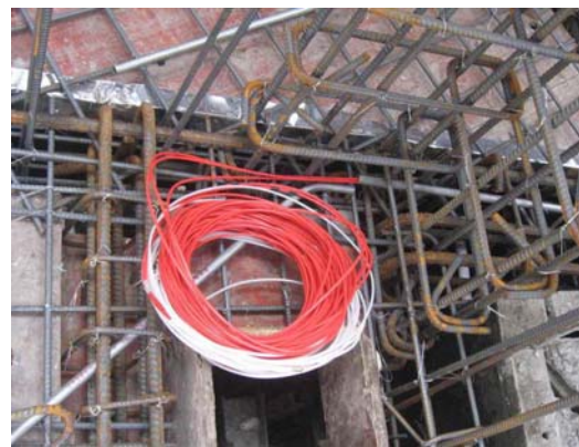
(d) Protection of cables
