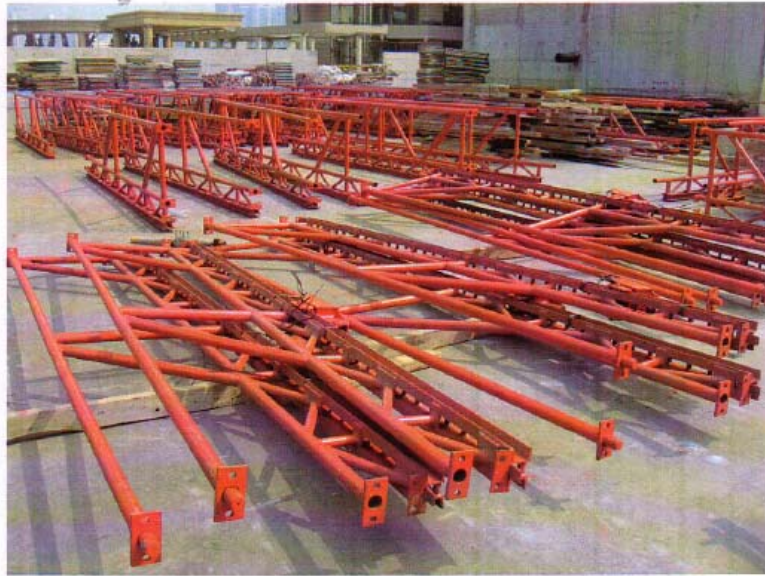
主框架：與金屬棚架相連，穩固棚架
