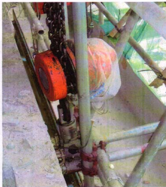
電動馬達底部裝置有重力探測器，提供數據參考及分析，以評估棚架爬升/下降表現。
