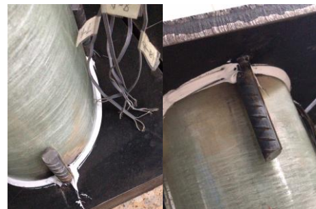
(d) Fixing the FRP tube and sealing the joints
