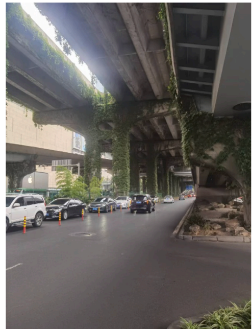
(d) Elevated highways in Chengdu, China
