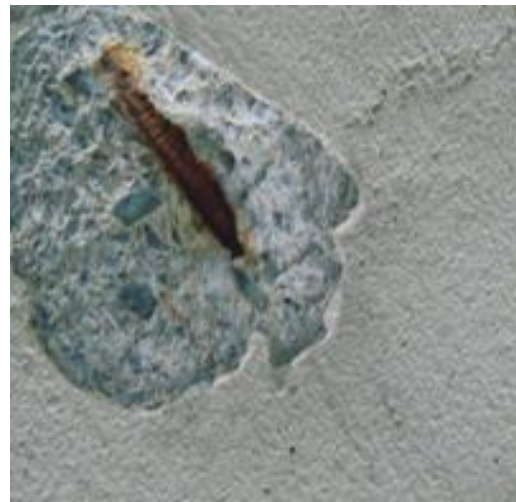
(d) Spalling-Image "D"
