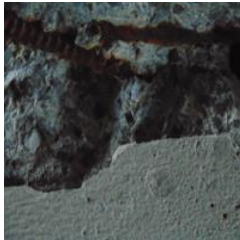
(d) Spalling-Image “D”
