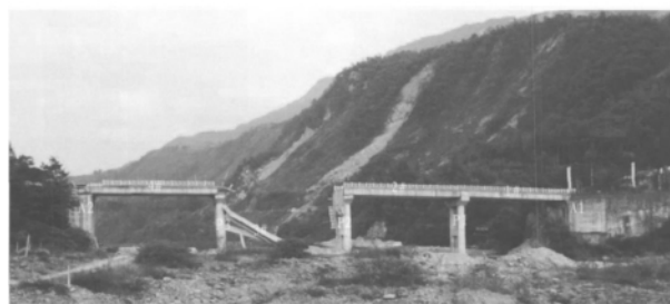
图 1 高原大桥破坏情况(镜向 NNE)
